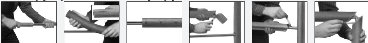
Изоляция Tubolit легко монтируется на все трубы и изгибы как по отдельности путем простого натяжения, если это возможно, так и на готовые трубопроводы посредством продольного разрезания трубок и последующей проклейки швов kleem Armaflex 520. Установка Tubolit проста, надежна и аккуратна. Рекомендуется использование
